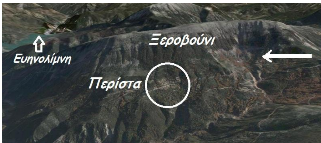
Η μεγάλη κατολίσθηση, που έγινε στις αρχές του 19ου αιώνα. Το 1/3 περίπου της πλαγιάς του Ξεροβουνιού αποκόπηκε (βέλος δεξιά της Περίστας).
