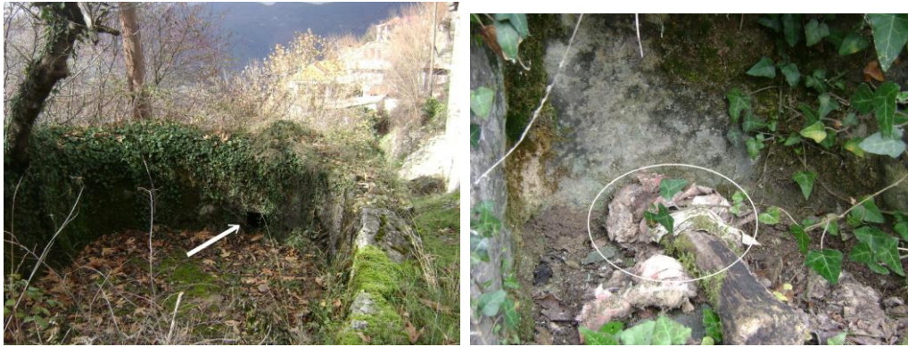
Μία γούρνα στεγνή από νερό και τη βουλώστρα στον πάτο. Το κυλινδρικό ξύλο με το πανί στην άκρη, που σφήνωνε την τρύπα εξόδου (βουλώστρα).
